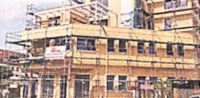
Das Holzhaus im Rohbau
