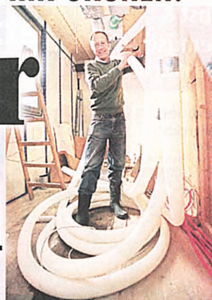
Im Technikraum der Wintermeyer Wohnung werden die Ab- und Zuluftrohre verlegt
