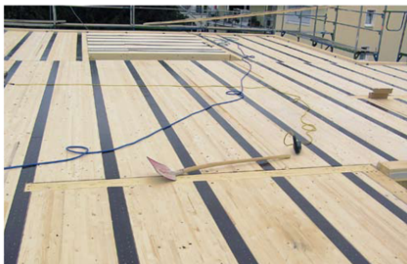
◀ 50 cm breite BS-Holz-Elemente bilden die Geschossdecken. Holzwerkstoffstreifen verbinden sie zu einer Scheibe
